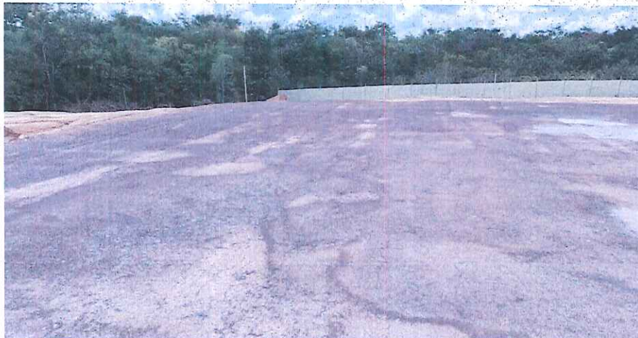
Registro Fotográfico: Compactación de Recebo.
